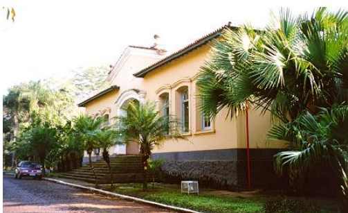
Prédio do Departamento de Patologia
