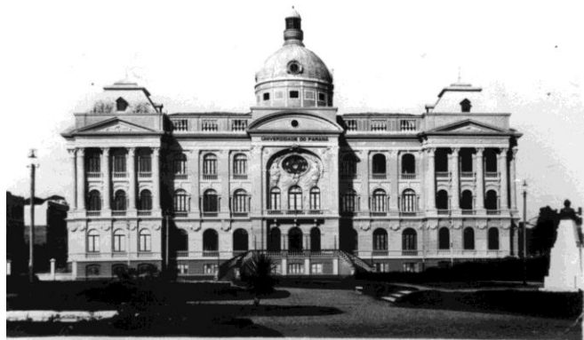
Prédio Histórico da UFPR antes da reforma de ampliação
